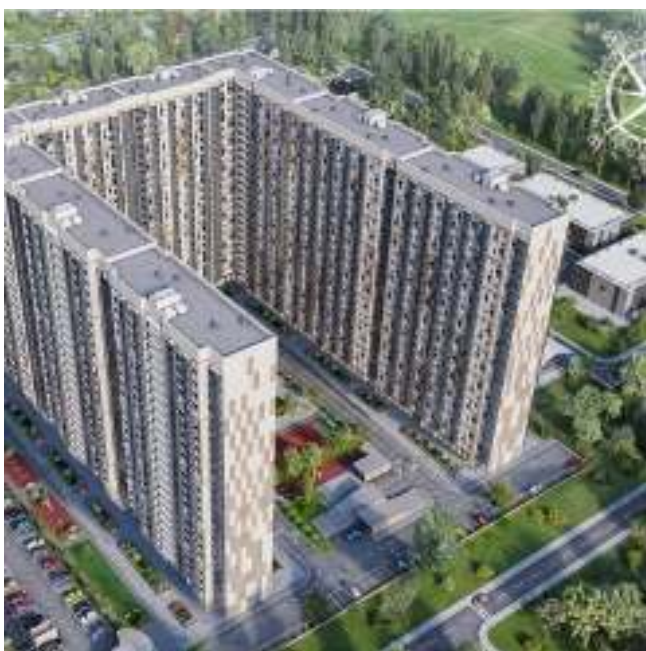
Город: Ростов-на-Дону Название объекта: ЖК West Side
